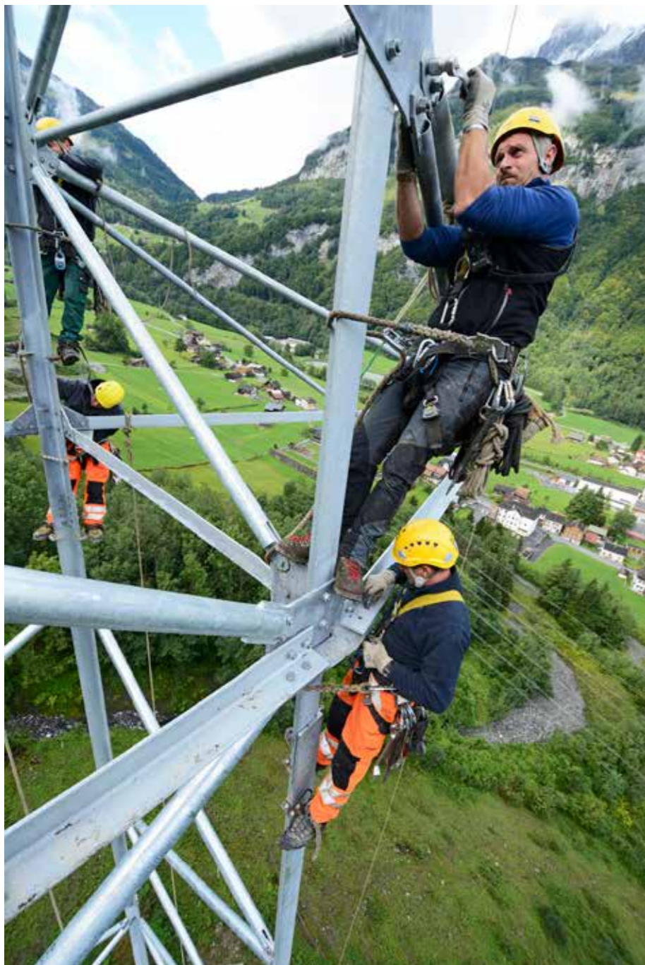
Einfach, aber sicher: Beim Ausbau mit Rohrdiagonalen und seitlichen Auslegern finden die Monteure dank Tritteisen Halt an den Eckstielen und schlingen eine Seilschleife um den Stahlträger, um sich zu sichern
