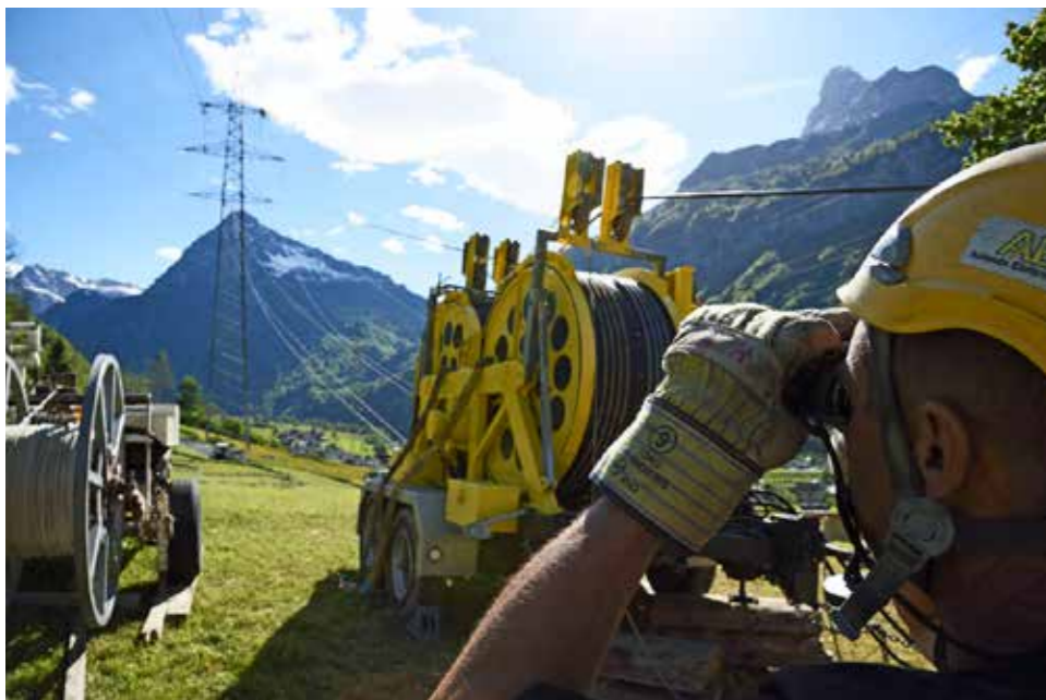
Kontrollierter Ablauf: Damit das Nylonseil nicht zu schnell von der Seiltrommel läuft, benutzt Norberto Stucchi ein Holzbrett als Bremse (oben). Dieselbe Aufgabe übernimmt beim Einziehen der Leiterseile die Bremsmotorrolle (unten). Chefmonteur Heiri Rhyner überprüft mit dem Feldstecher, ob die Leiterseile ausreichend gespannt sind
